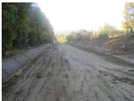
Drum în reconstrucție
