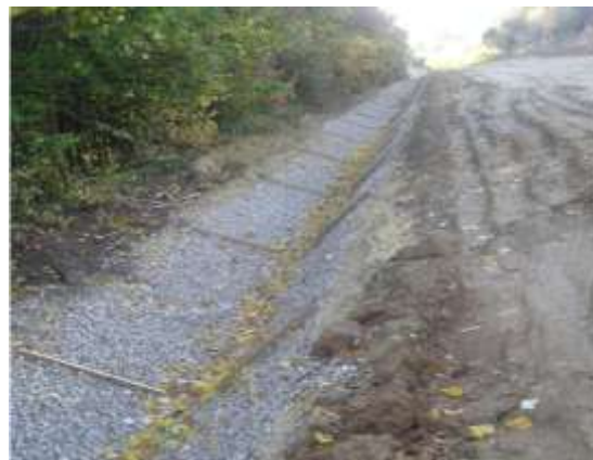
Drum în reconstrucție
