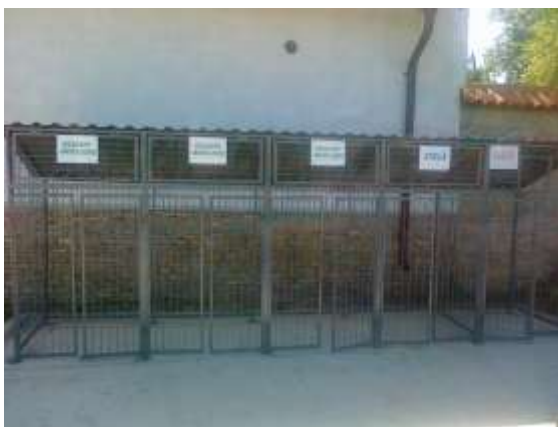
Platforme cu carcase metalice instalate
