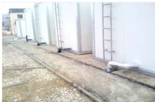
Stația de epurare din or. Călărași
