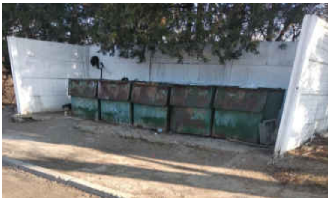
Imaginea nr.25 . Platformă de colectare a deșeurilor menajere din str.Păcii , or. Rezina.
