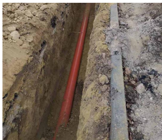
Foto 8. Extinderea sistemului de canalizare
