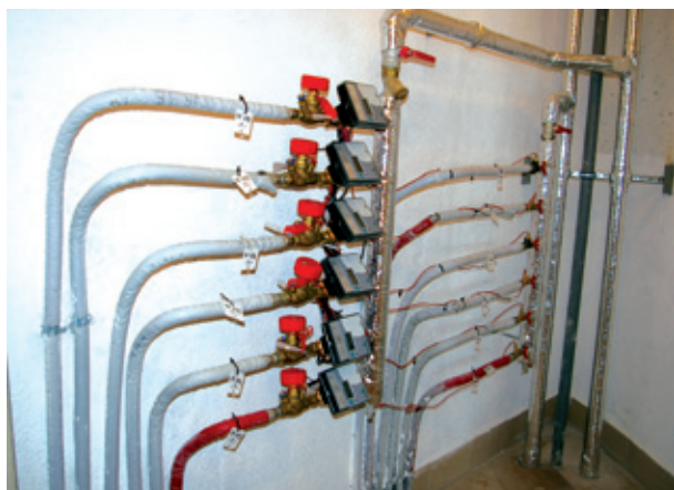
Figura 5.9. În interiorul unei încăperi tehnice de etaj, sunt ilustrate contoarele individuale de ET și conductele de încălzire separate pentru fiecare apartament, într-un bloc nou din Chișinău, conectat la SACET (sursa: Fotografii Encon).
