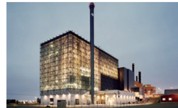
Figura 17.4. CET modern de incinerare a deșeurilor în apropiere de Linköping, Suedia. Capacitatea este de circa 24 tone de deșeurii pe oră, 65 MW energie termică pentru SACET și 19 MW energie electrică. (sursa: Usital)
