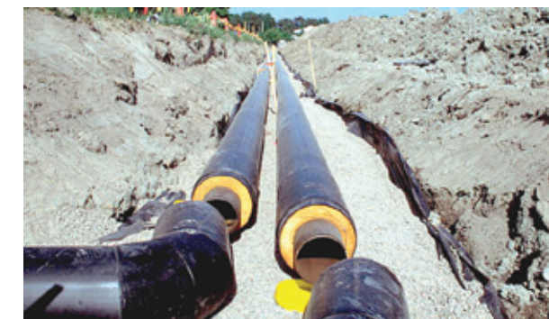
Figura 5.4. Instalarea rețelilor termice moderne (sursa: www.alldaberg.se).
