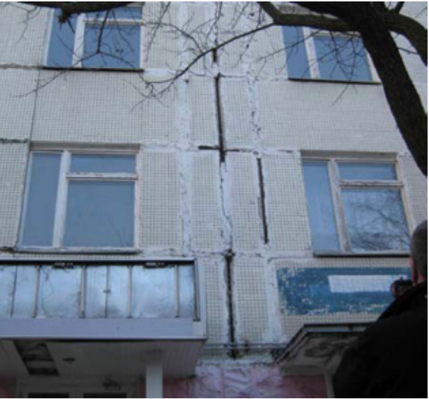
Figura 11.2. O clădire care necesită etanșarea rosturilor dintre elementele din beton ale pereților și izolarea pereților în întregime. Sunt prezentate o fotografie și o termografie a clădirii (sursa: Fotografii Encon).
