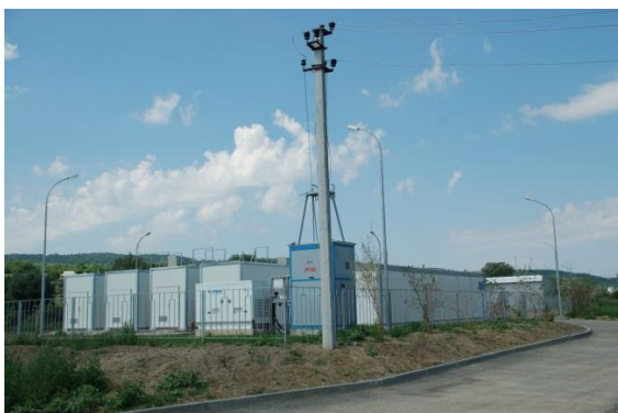
Stația de pompare nr. 1 construită
