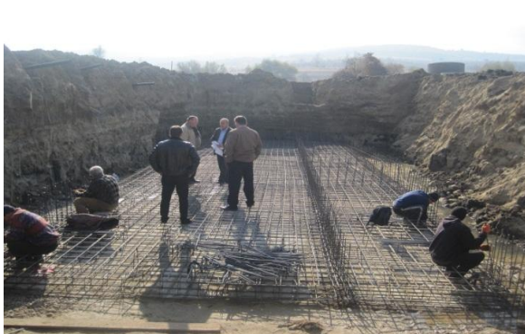
Construcția rezervorului de acumulare a apelor reziduale
