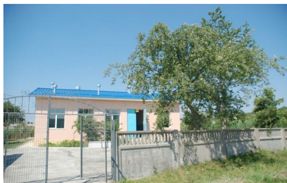
Stația de epurare construită
