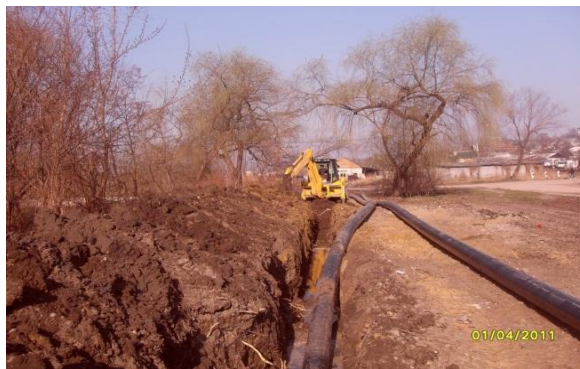
Construcția rețelei de canalizare
