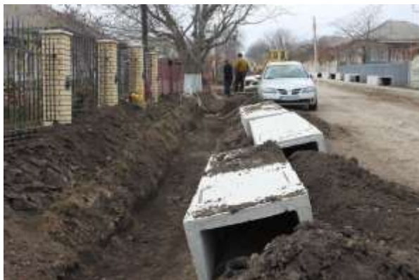
Montarea rigolelor prefabricate
