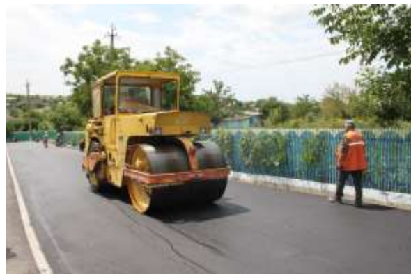
Lucrări de asfaltare
