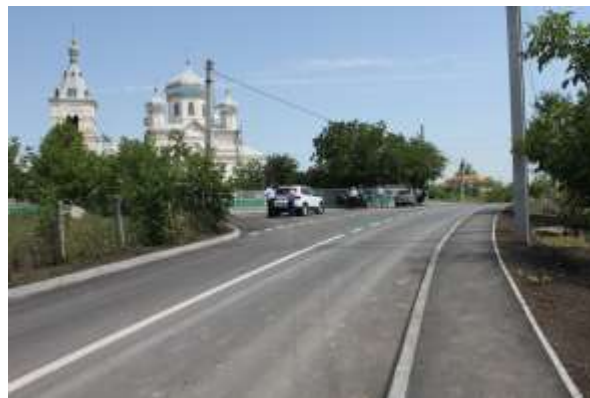
Drum asfaltat renovat
